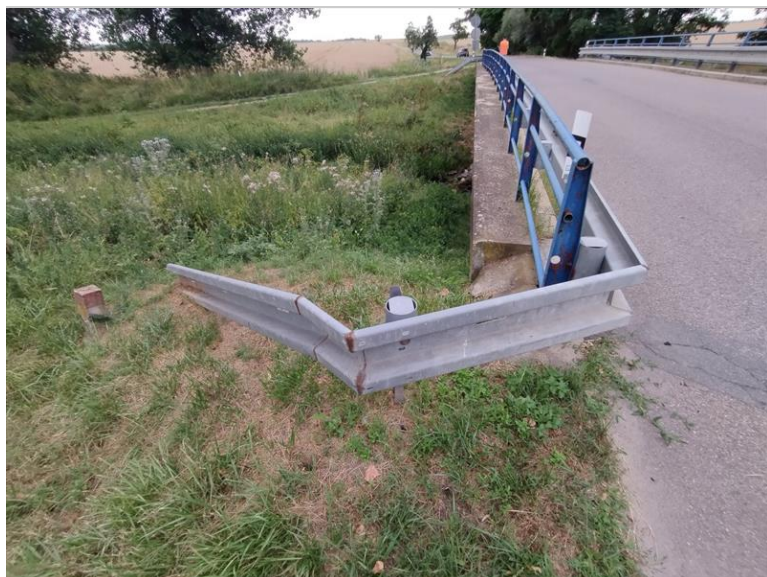
Zalomení svodnice zábradelního svodidla
