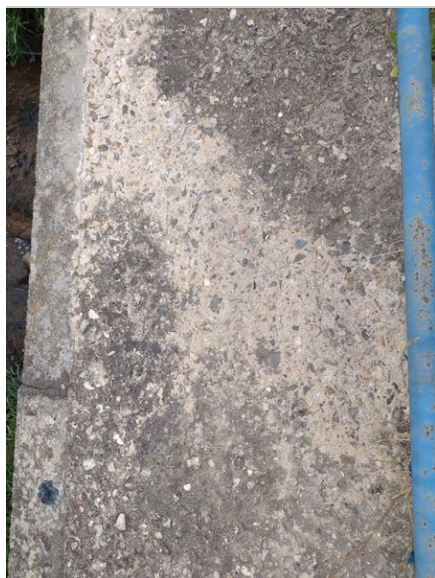
degradace povrchu římsy na mostě
