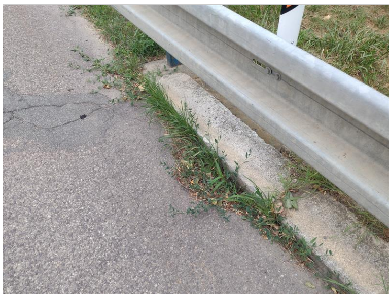
Vegetace ve spáře mezi vozovkou a obrubou
