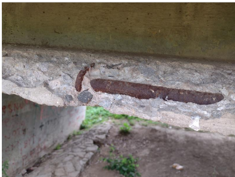
Uložená hrana pravého krajního nosníku v poli 3
