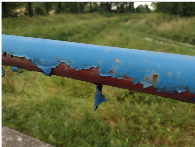
Stav PKO zábradelního svodidla
