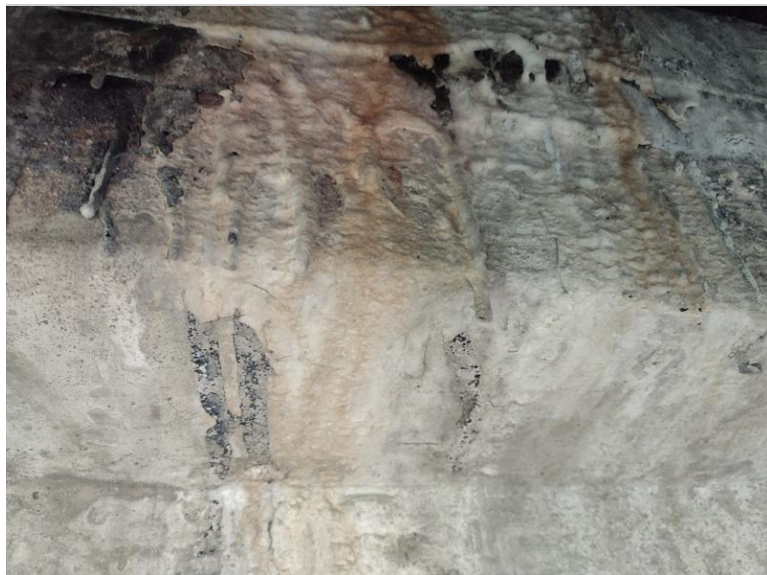
Silné zatékání na boku NK v poli 1
