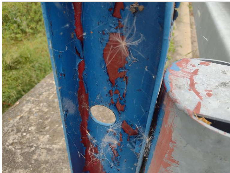
Stav PKO zábradelního svodidla
