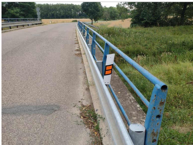
degradace povrchu římsy na mostě
