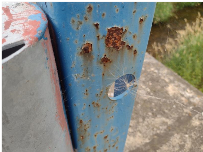
Stav PKO zábradelního svodidla
