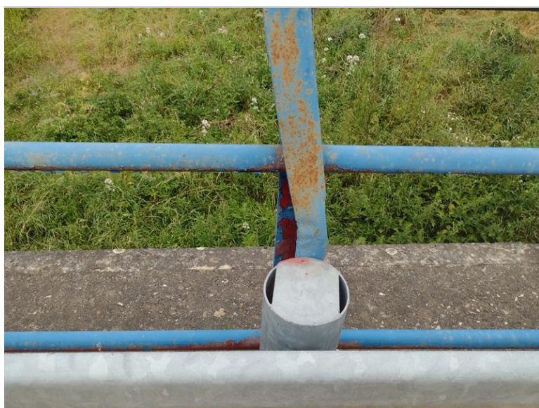
Deformace sloupku zábradelního svodidla na levé straně v poli 3
